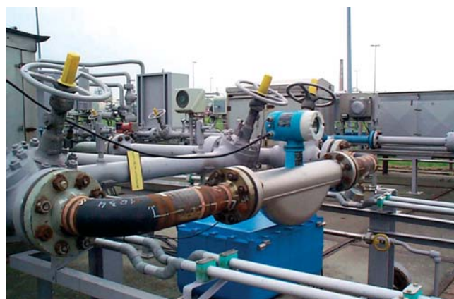
Obr.2 Meranie prietoku etylénu pomocou prietokomera Promass F svetlosti DN80 v spoločnosti DOW Chemicals
