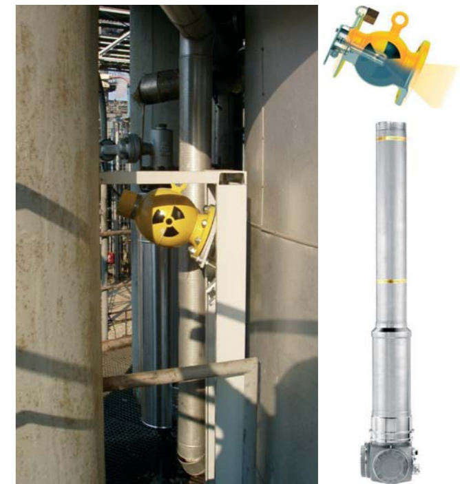
Obr.4 Kontinuálne rádiometrické meranie výšky hladiny inštalované na Slovensku
