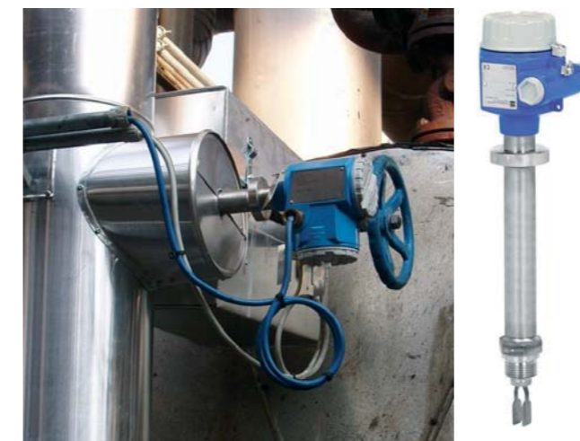
Obr.6 Vysokoteplotný vibračný spínač Liquiphant pre teplotu do +280 °C inštalovaný u slovenského zákazníka v prostredí SNV
