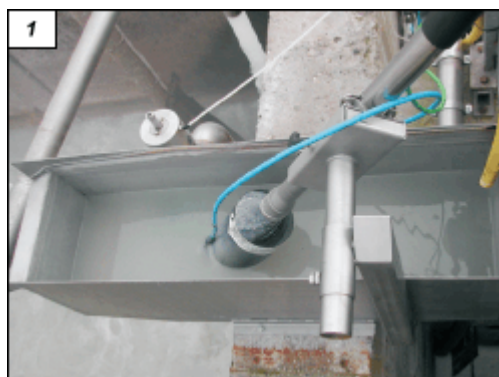
Obr. 1. UV senzor CSS70 instalovaný v obtoku přívodního kanálu čistíčky odpadních vod
